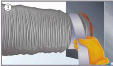
3.- Vuelva a colocar el aislamiento y la cubierta metálica. Envuelva la cubierta con al menos dos vueltas de cinta para ducto. También puede usarse una abrazadera.
