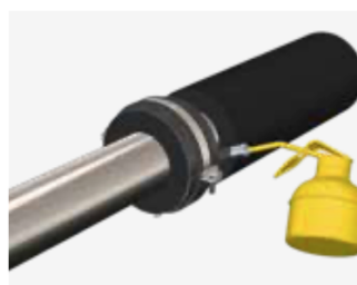
Pegue el soporte al aislante material.
