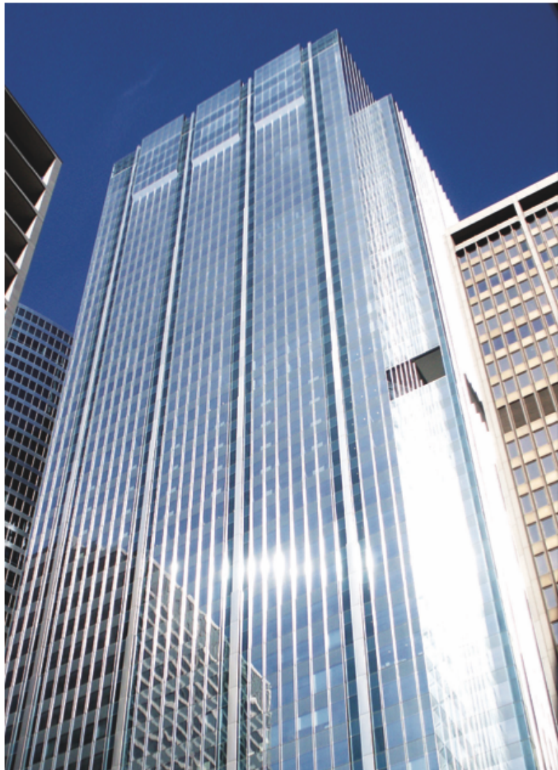
Los productos de lana mineral Thermafiber® Safing y FireSpan® proporcionan los componentes críticos del perímetro del sistema de contención de incendios en el edificio 111 South Wacker en Chicago, IL. El aislamiento de lana mineral Thermafiber® también contribuyó a la calificación de oro LEED® del edificio.
